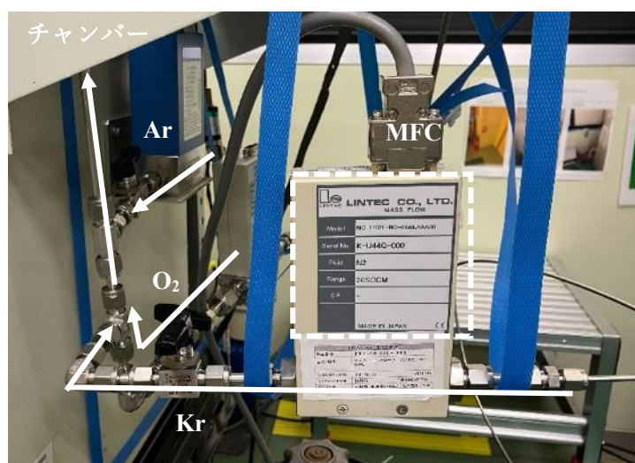
図 2-6 ガス配管整備
