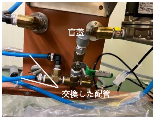
(b)冷却水用配管の交換
